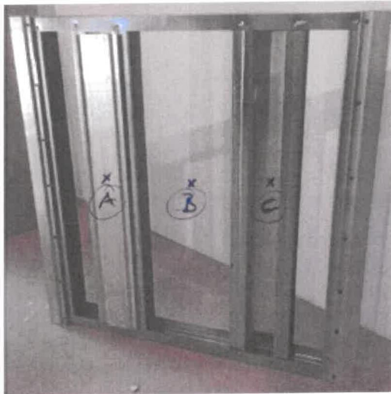
**Bild 2: Metallständerwerk mit vertikal, wechselseitig eingebauten Sonderprofilen „cm VARIO“ (A) u. (C) sowie vertikal jeweils seitlich eingebauten Endprofilen „cm VARIO“**
